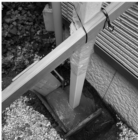
▲ 図 3：ドライコンクリートを流し込み木材で固定
