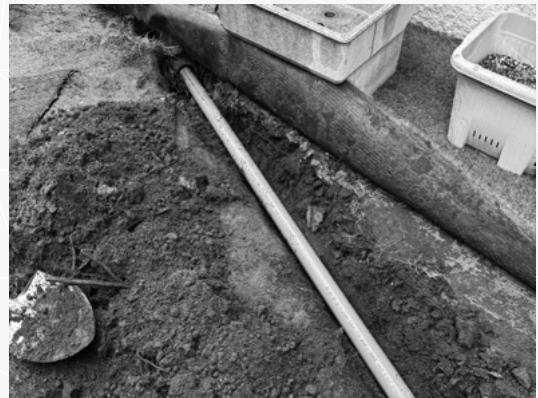
▲ 図 11：雨水枡への配管
